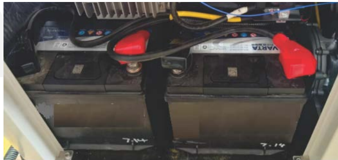
Fig. 6-2: Conecte el cable de la batería
